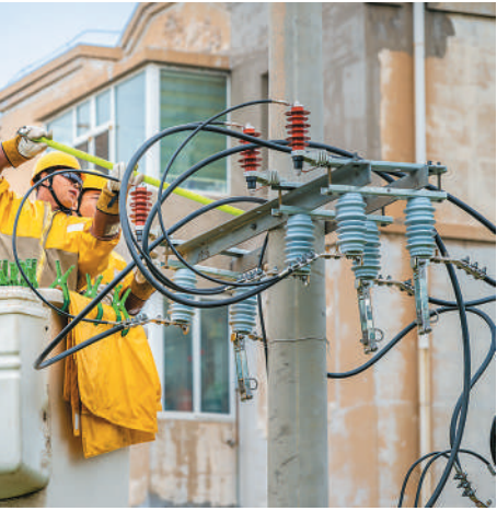
辽宁省葫芦岛市龙港区,国网葫芦岛供电公司工作人员开展10千伏线路带电接引作业。 牟 超摄(人民视觉)
