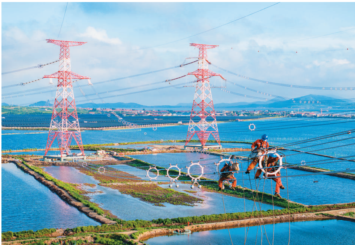
位于山东省烟台市的1000千伏海阳辛安核电送出特高压工程, 输电线路全长约80千米, 目前工程即将进入收尾阶段, 建成后将为胶东半岛核电及海上新能源基地的电力送出提供保障。图为工人在输电线路开展高空作业。 徐 可摄 (人民图片)
