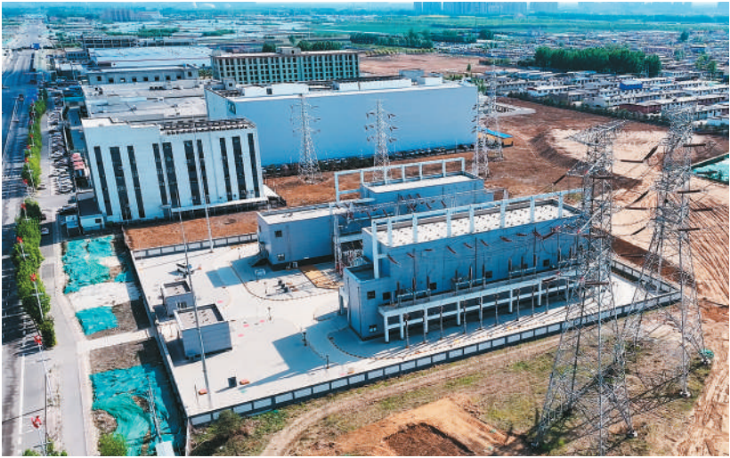
图为君瑞220千伏变电站全景。
