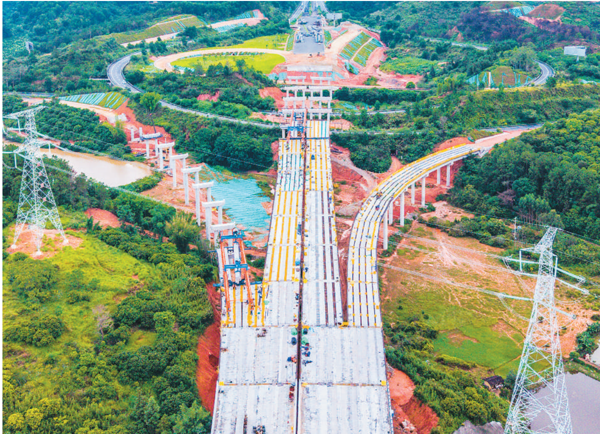
广西壮族自治区梧州市环城高速南段连接广昆（广州—昆明）高速与包茂（包头—茂名）高速公路，该项目建成后可进一步完善广西高速公路网，提升区域陆海新通道衔接效率，助力区域经济高质量发展。图为梧州市环城高速公路南段龙圩区新地镇洞心村立交桥施工现场。
