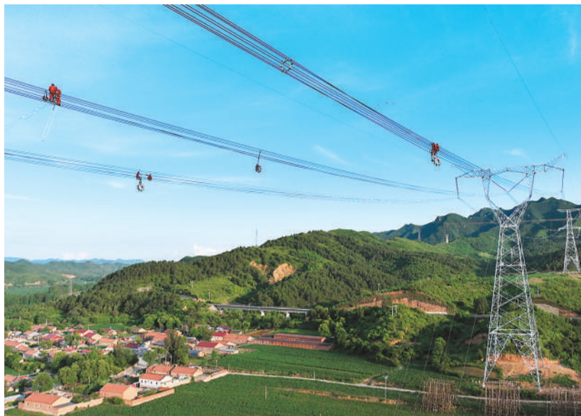
图为6月17日，在大同一怀来—天津南1000千伏特高压输电线路工程河北省承德段，电力工人进行高空作业。新华社记者 杨世尧摄
