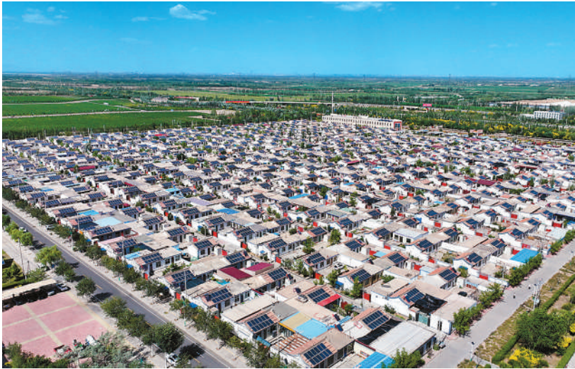
宁夏回族自治区银川市闽宁镇原隆村推进屋顶光伏项目建设,探索“光伏+农业”发展模式,持续带动村民增收致富。图为原隆村的屋顶光伏项目。 袁宏彦摄(人民视觉)
