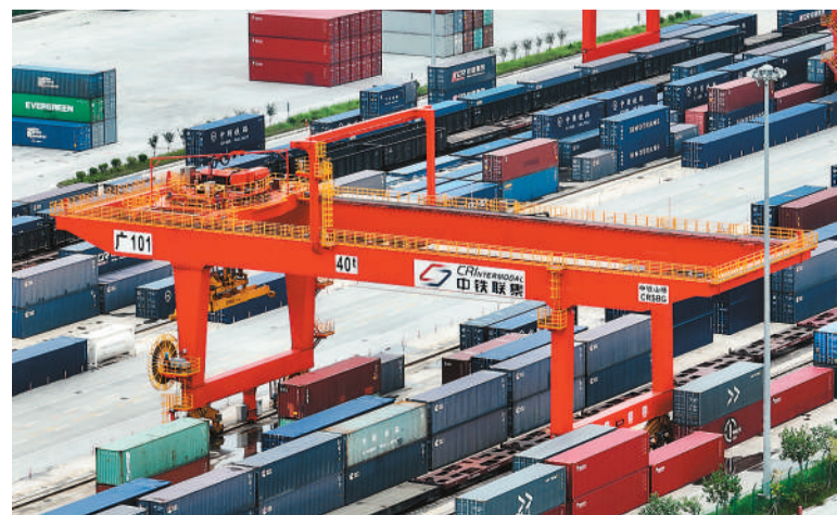
广州国际港门吊有序作业，集装箱规范码放，保障粤港澳大湾区国际班列顺畅开行。罗希摄
