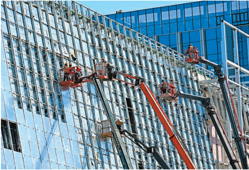
在北京市首钢园，服贸会永久会址项目正加紧建设。 李文明摄（人民视觉）
