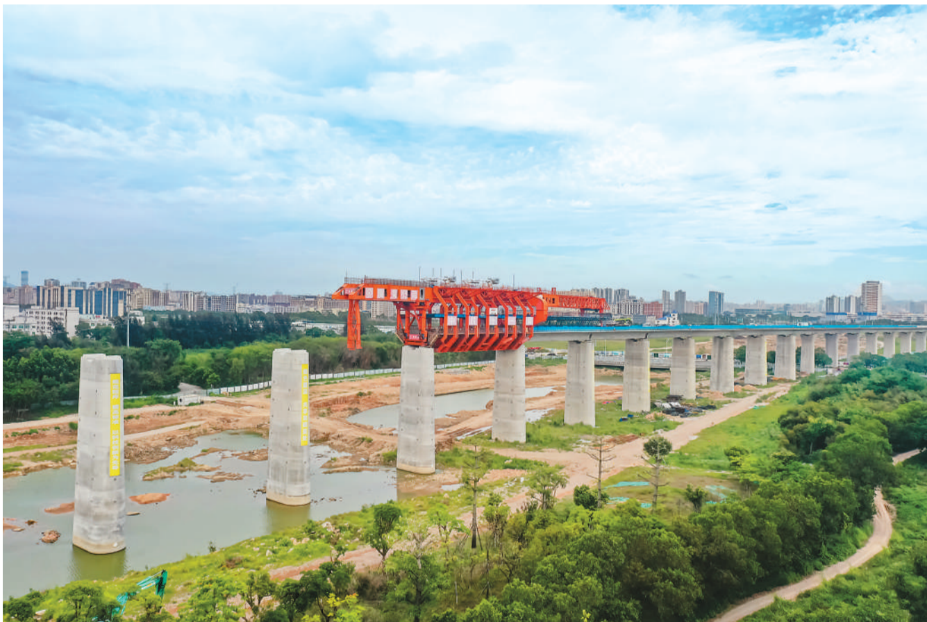
连日来,位于广东省东莞市的深江铁路跨沿江高速特大桥建设正酣。深江铁路是国家“八纵八横”高铁网沿海通道的重要组成部分,建成通车后将实现深圳前海与广州南沙半小时高铁互联互通,助力打造“轨道上的大湾区”。图为深江铁路跨沿江高速特大桥施工现场。闵辉摄(人民视觉)
