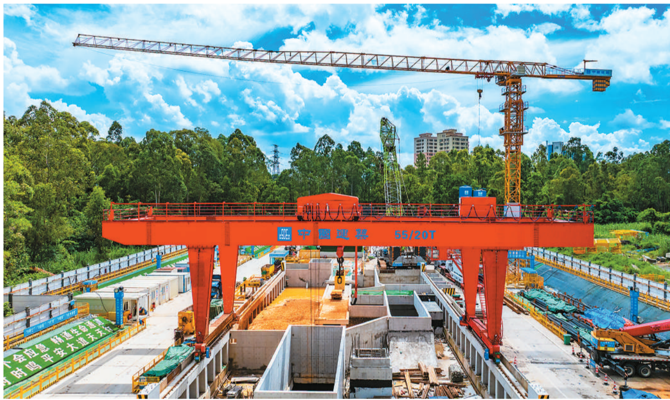
近日，由中建四局承建的深圳地铁25号线六工区石龙站—创意城站区间右线盾构机顺利始发，标志着该控制性区间进入双线并行掘进阶段。该区间全长1713.146米，建成后将进一步完善深圳轨道交通及粤港澳大湾区基础设施建设。图为施工现场。
