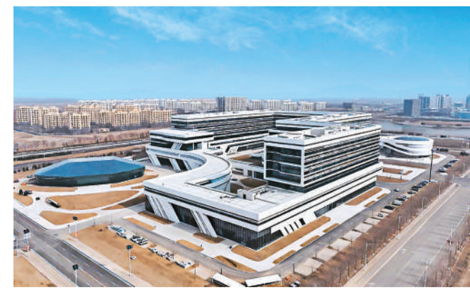
近日，由中建五局承建的国家盐碱地综合利用技术创新中心建设项目（科研创新中心、高标准温室）建成投用。作为山东省重点工程、国家盐碱地综合利用协同创新体系“1+3+16+N”的中心总部，将为盐碱地生态保护与综合利用提供源头技术供给，为国家构建盐碱地现代农业产业体系提供坚强技术支持。 张博敏摄
