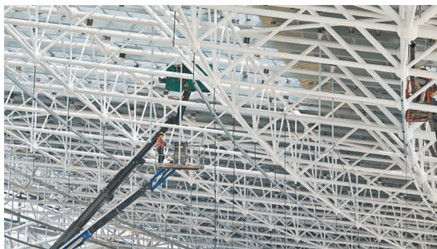
济南遥墙国际机场二期改扩建工程T2航站楼项目现场,工人进行檐口吊项施工。孙裕泽摄
