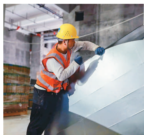
工人在琴澳创新产业园现场施工作业。李喜摄
