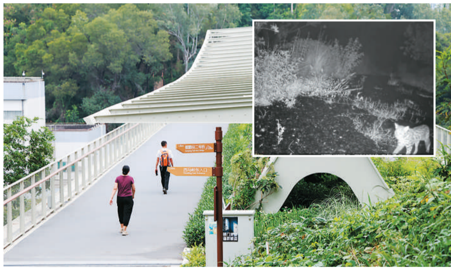
大图:深圳鲲鹏径三号桥,一边是人行通道,一边是野生动物通道。
