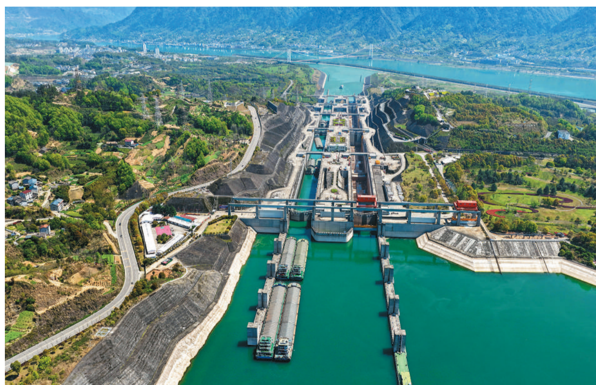
长江三峡通航管理局统计数据显示,2026年一季度,三峡枢纽累计运行3128闸(扇)次,通过船舶9212艘次,累计通过量达3623.3万吨,共保障983.4万吨民生物资安全便捷过坝。其中三峡升船机通过旅客10.6万人次,同比增长50.5%。图为湖北省宜昌市,三峡北线船闸正在有序运行,三峡南线船闸正在实施计划性停航检修。
