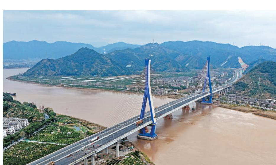
正在建设中的灵江特大桥是浙江省甬台温高速公路改扩建台州北段项目关键控制性工程,全长1690米,由南北引桥和主桥组成,其中主桥全长700米,主跨380米。
