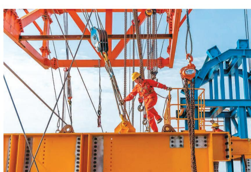
工人在进行缆载吊机拼装作业。
