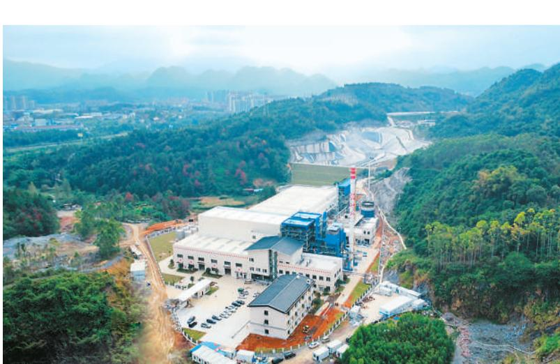
近日,由中建四局华南公司承建的全国小型垃圾焚烧示范工程——广东乳源县城垃圾焚烧处理设施建设项目进入系统联合调试。项目位于广东省韶关市,投用后将实现年处理生活垃圾及餐厨废弃物共15万吨,年产能机肥5万吨,减排二氧化碳超3.5万吨。项目采用“湍动床气化焚烧+水热裂解制肥”组合技术,构建“废物—能源—资源”绿色循环体系,助力粤港澳大湾区“无废城市”建设。图为项目现场实景。
