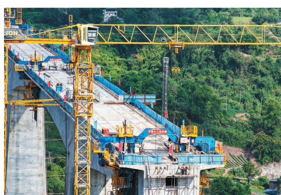
9月24日，由中铁十二局承建的渝万高铁(新建重庆至万州高速铁路)五步河双线特大桥主跨顺利合龙。渝万高铁正线全长251公里，设计时速350公里，是国家“八纵八横”高速铁路主通道包(银)海、京昆通道的重要组成部分。五步河双线特大桥主跨总跨度392米，最高墩达105米，此次合龙为渝万高铁全线按期通车奠定基础。
