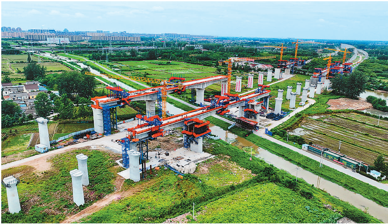
6月24日，由中铁上海工程局承建的宁淮铁路5标六合特大桥跨招兵河连续梁顺利完成合龙，为后续架梁作业、实现全线贯通打下坚实基础。宁淮铁路铁路是长三角城际轨道交通网的重要组成部分，建成后将使南京与淮安实现1小时直达。宁淮铁路5标六合特大桥位于南京市六合区，全长约27.2公里，特殊孔跨多、技术标准及安全风险高、环保要求严，是全线的重点控制性工程。
