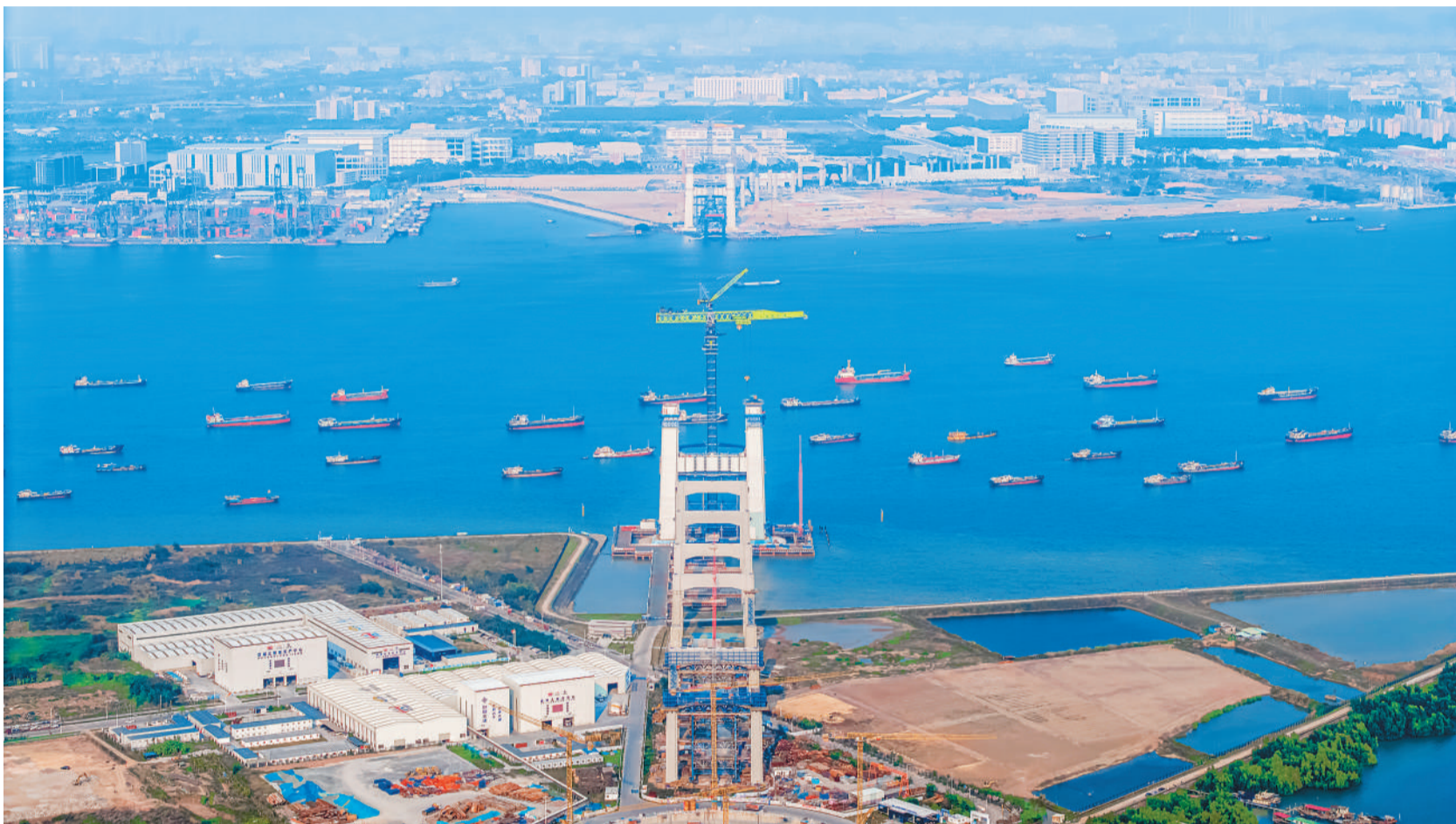
近日，广东广州狮子洋通道项目关键控制性工程——狮子洋大桥完成首道钢横梁架设。狮子洋通道是连接珠江东西两岸的超大型跨海多层复合公路通道工程，全长约35公里。作为项目关键控制性工程，狮子洋大桥采用主跨2180米双层钢桁梁悬索桥的方案“一跨过江”。图为狮子洋大桥施工现场。吕华当摄（人民图片）
