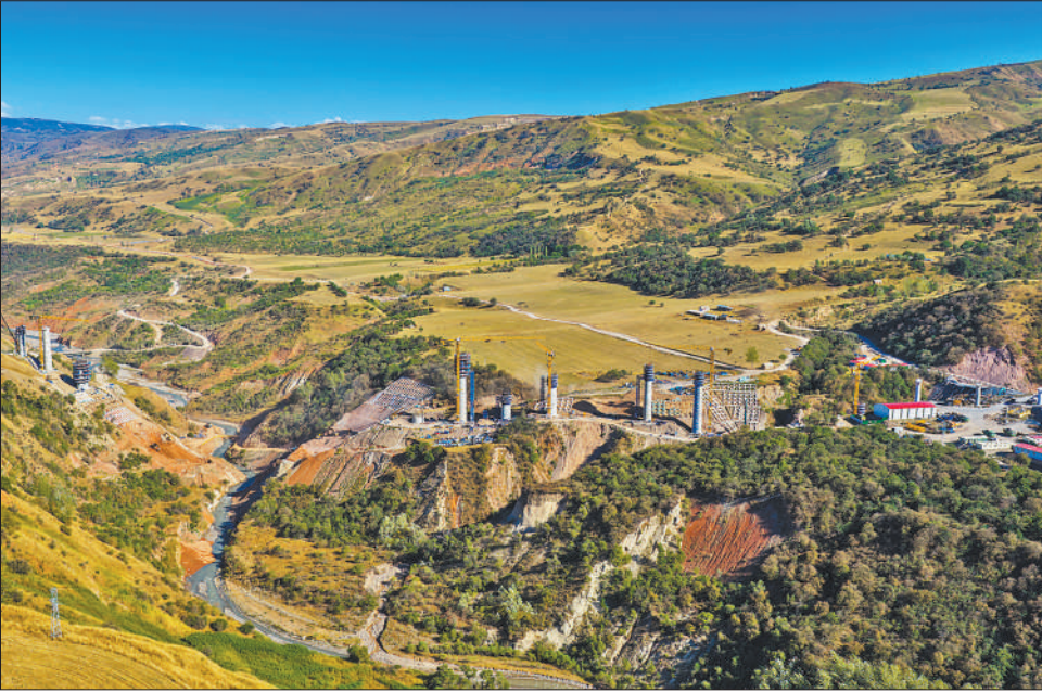
中吉乌铁路全线最高桥梁克奇阿勒特河特大桥建设现场。
