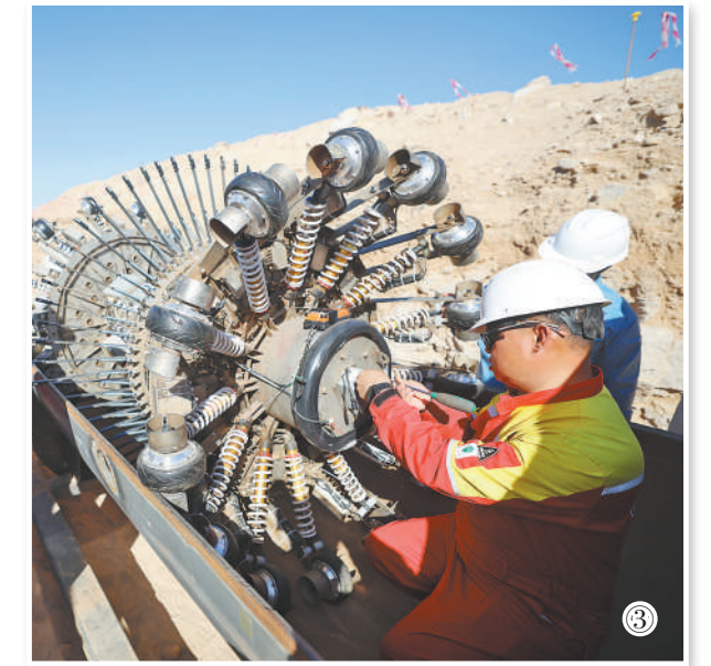
图①：项目管线施工现场。 杨 韦摄 图②：项目员工进行安全模拟培训。 本报记者 任皓宇摄 图③：项目使用的中国产自爬行智能通球设备在进行使用前调试。 杨 韦摄 版式设计：张芳曼
