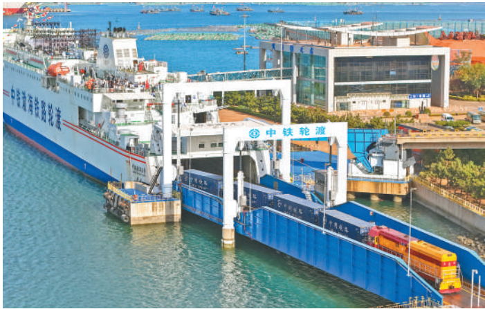
在山东烟台北站,货物列车车厢正进入“中铁渤海3号”火车滚装船。烟台至辽宁大连铁路轮渡平稳运行,保障物流通道畅通。 唐克摄(人民视觉)
