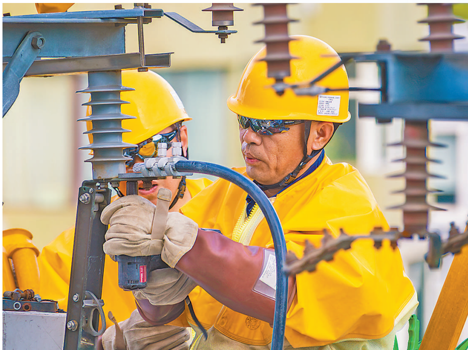
辽宁葫芦岛市龙港区,供电公司作业人员开展带电作业。牟超摄(影像中国)
