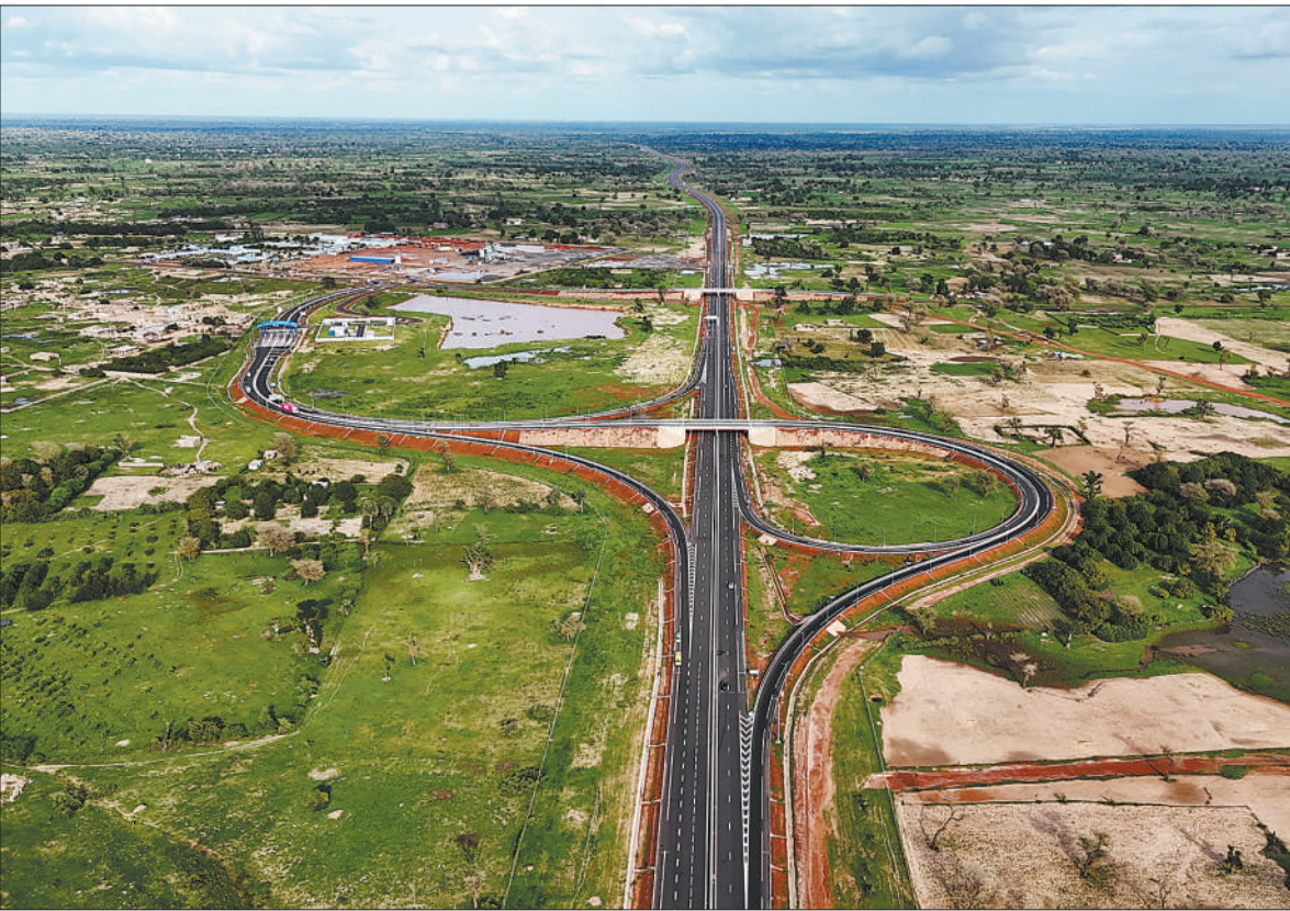
由中国路桥工程有限责任公司承建的塞内加尔姆布尔—考拉克高速公路日前通车。该高速公路连接塞内加尔西部沿海城市姆布尔与中部城市考拉克，全长99.2公里，双向四车道，设计最高时速130公里。图为建成后的姆布尔—考拉克高速公路。
