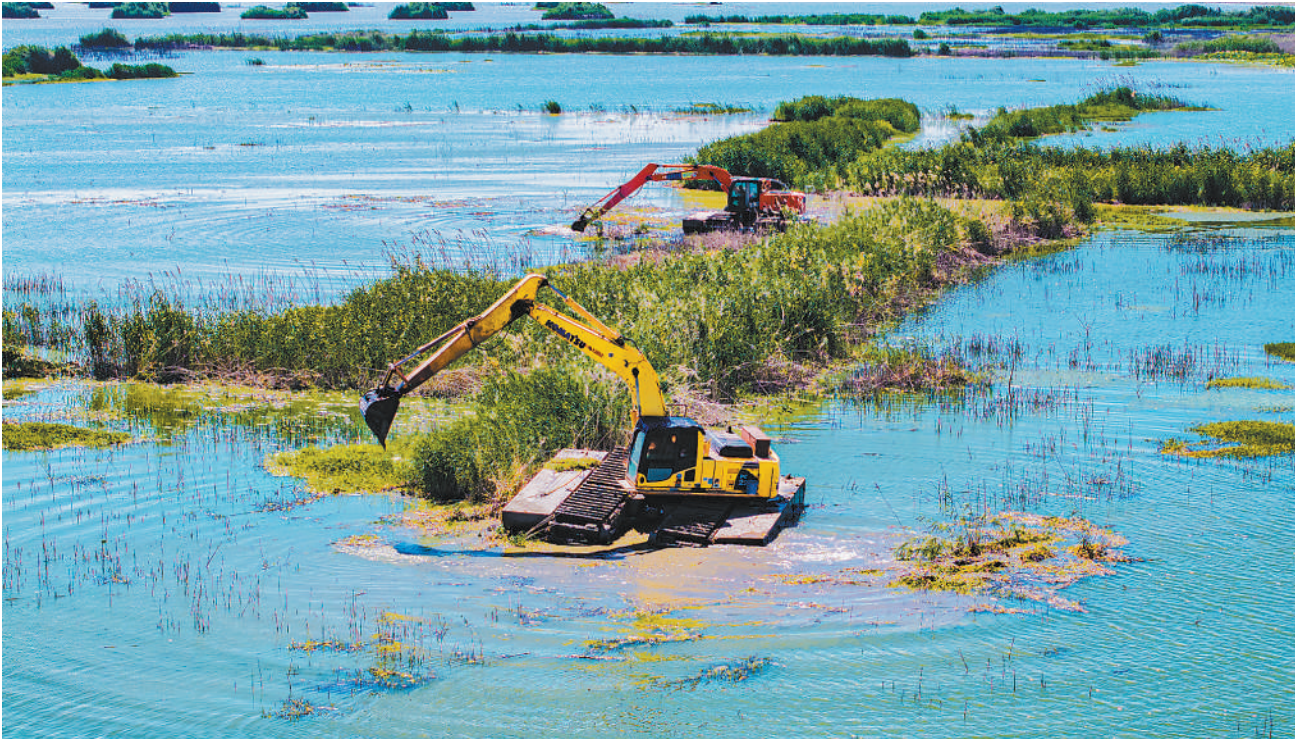
“十四五”以来,江苏洪泽湖保护区修复退化湿地1.5万余亩,完成退渔还湿、退圩还湖13.3万亩,不断增强湿地生态系统的稳定性。图为近日,毗邻洪泽湖的江苏泗洪县半城镇,湿地生态人工小岛正在有序建设。刘 烨摄(影像中国)
