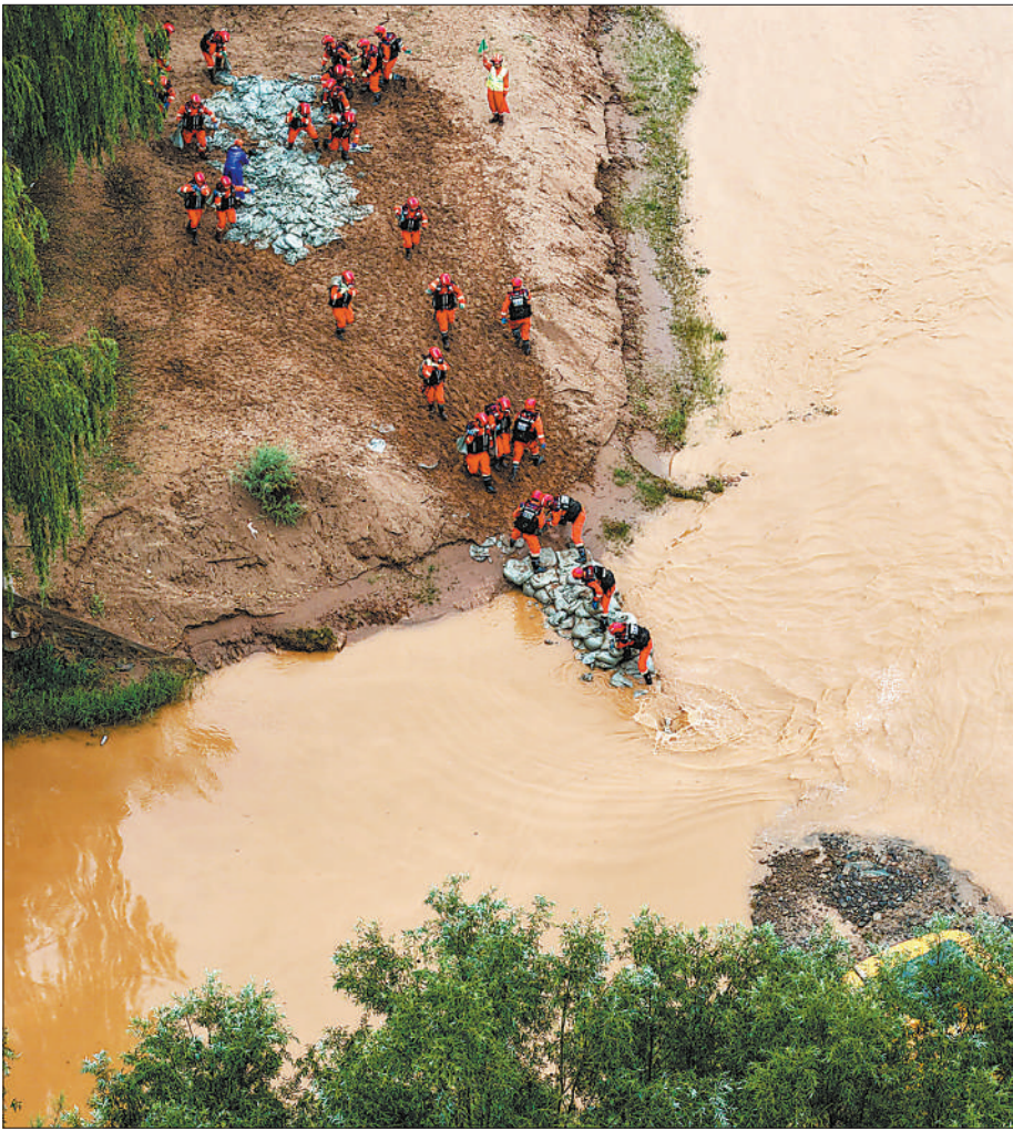
甘肅白銀市水川鎮黃河水域，消防員在進行河道堤防加固演練。 梁皓清攝（影像中國）
