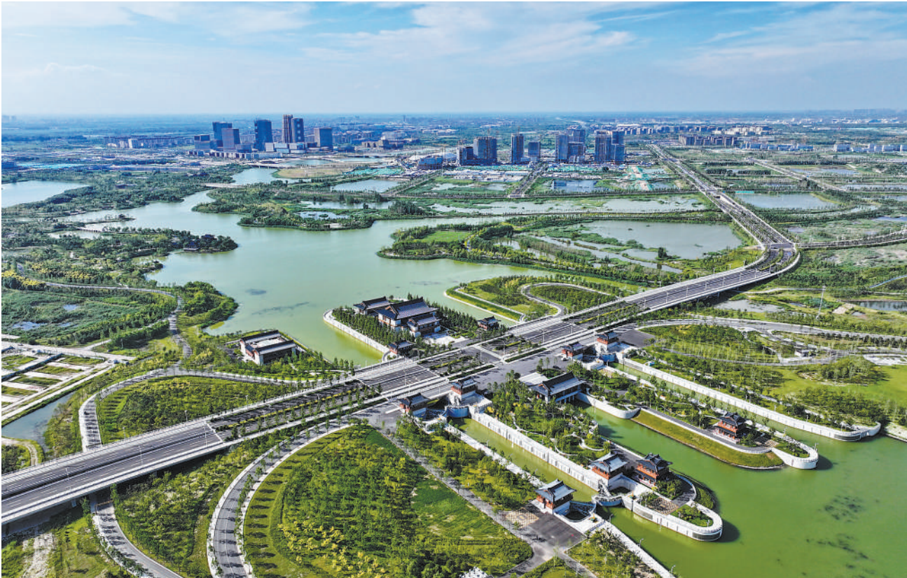
位于河北雄安新区启动区与白洋淀交会处的南河枢纽总占地面积约450亩，是集防洪屏障、文旅观光、生态体验、内河通航等多功能于一体的综合性水利枢纽。目前该枢纽工程已全部完工，正式转入运营阶段。
