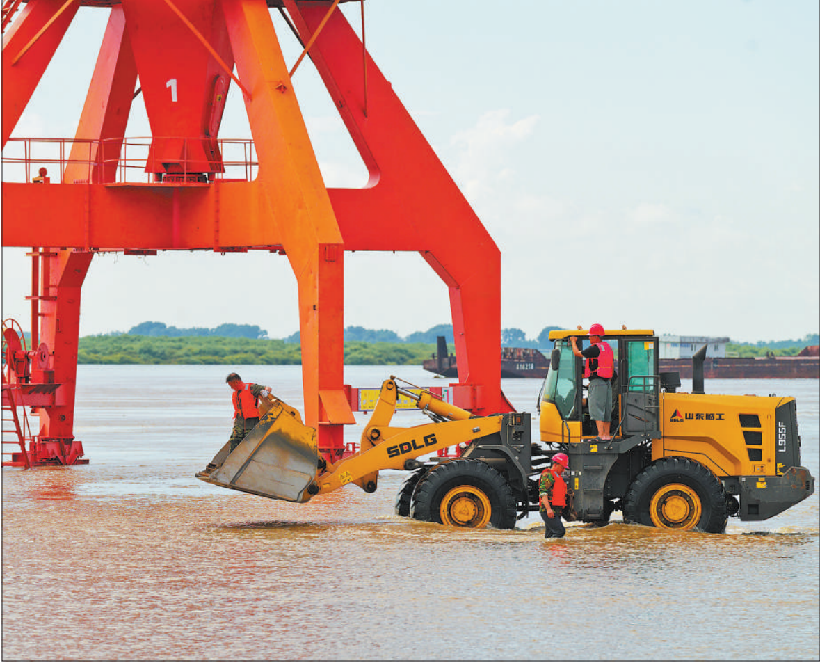
受上游来水影响,松花江洪峰预计8月7日抵达黑龙江省同江市,黑龙江干流洪峰8日晚间到来。为迎战“双洪峰”,同江市全力开展隐患排查、加固子坝等工作。图为8月5日,工作人员在同江龙航港务有限公司码头上进行设备维护。 新华社记者 张 涛摄
