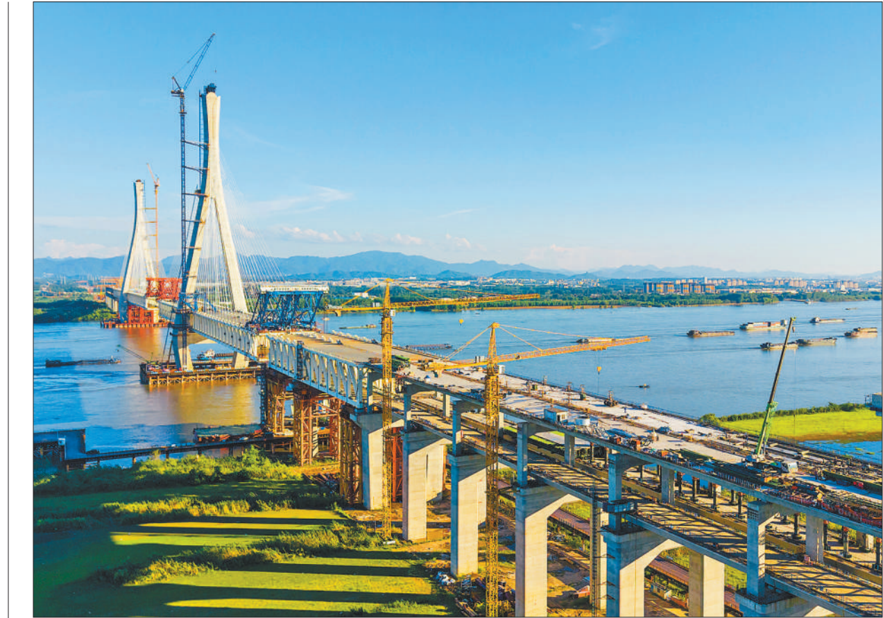
池州长江公铁大桥连接安徽池州市贵池区和铜陵市枞阳县,全长3.1公里,其中主桥长1768米,大桥按照“公路+城际铁路+城市轨道交通”合并过江的标准建设,上层作为宁枞高速公路的过江通道,按双向6车道设计,下层为设计时速250公里的两线合设铁路。图为7月31日拍摄的池州长江公铁大桥施工现场。 刘伯顺摄(影像中国)
