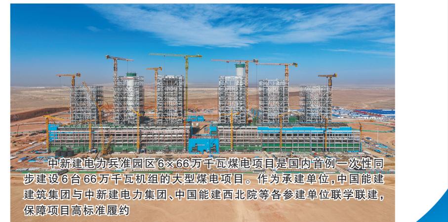
中新建电力兵团园区6×66万千瓦煤电项目是国内首例一次性同步建设6台66万千瓦机组的大型煤电项目。作为承建单位,中国能建建筑集团与中新建电力集团、中国能建西北院等各参建单位联学联建,保障项目高标准履约
