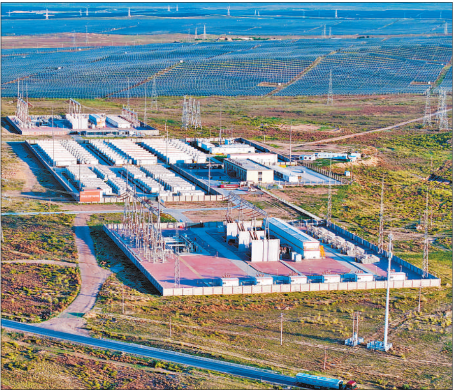
近年来,宁夏充分利用自然资源禀赋,在沙漠、戈壁、荒滩上发展光伏、风电、储能等清洁能源产业。图为7月21日,位于宁夏灵武的国能宁东200万千瓦复合光伏基地。 袁宏彦摄(影像中国)
