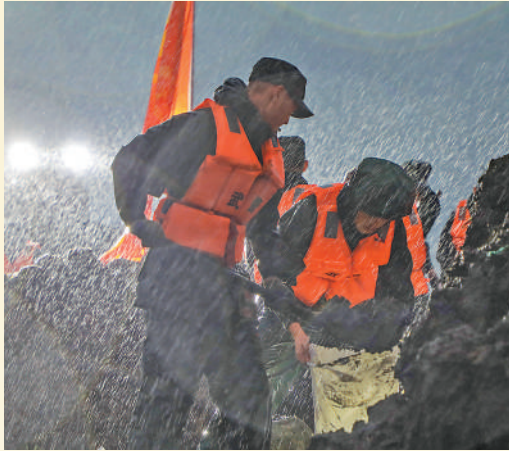
▲7月13日,辽宁沈阳市蒲河新民段,武警官兵在加固堤坝。
