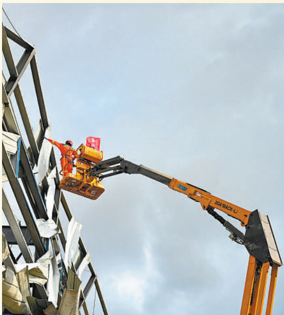
▲湖北黄冈市组织各类救援力量,展开抢险救灾各项工作。图为7月7日,在黄冈市黄州区东湖街道,救援队伍开展重建作业。
