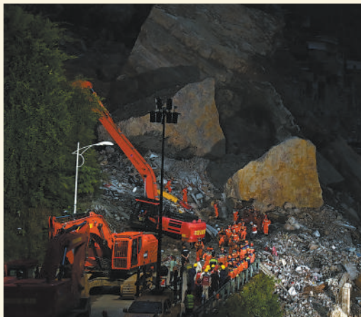
▲7月18日晚,重庆彭水苗族土家族自治县山体崩塌灾害现场,救援人员正在进行搜救作业。
