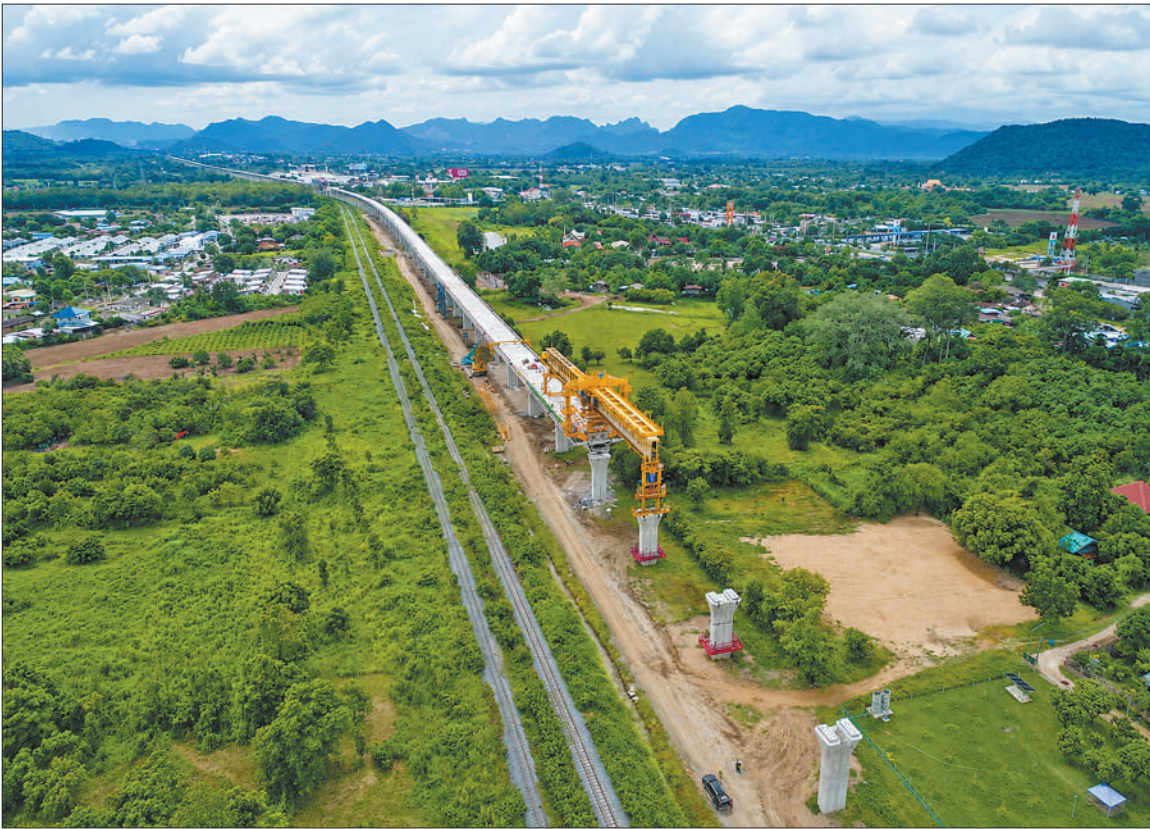
中泰铁路是两国高质量共建“一带一路”的旗舰项目,也是泰国首条采用中国标准设计建设的高速铁路。图为近日,在沙拉武里府中泰铁路C3—1标段英莱特大桥施工现场,中铁十局建设者们抢抓施工有利时机,全力保障项目建设进度。
