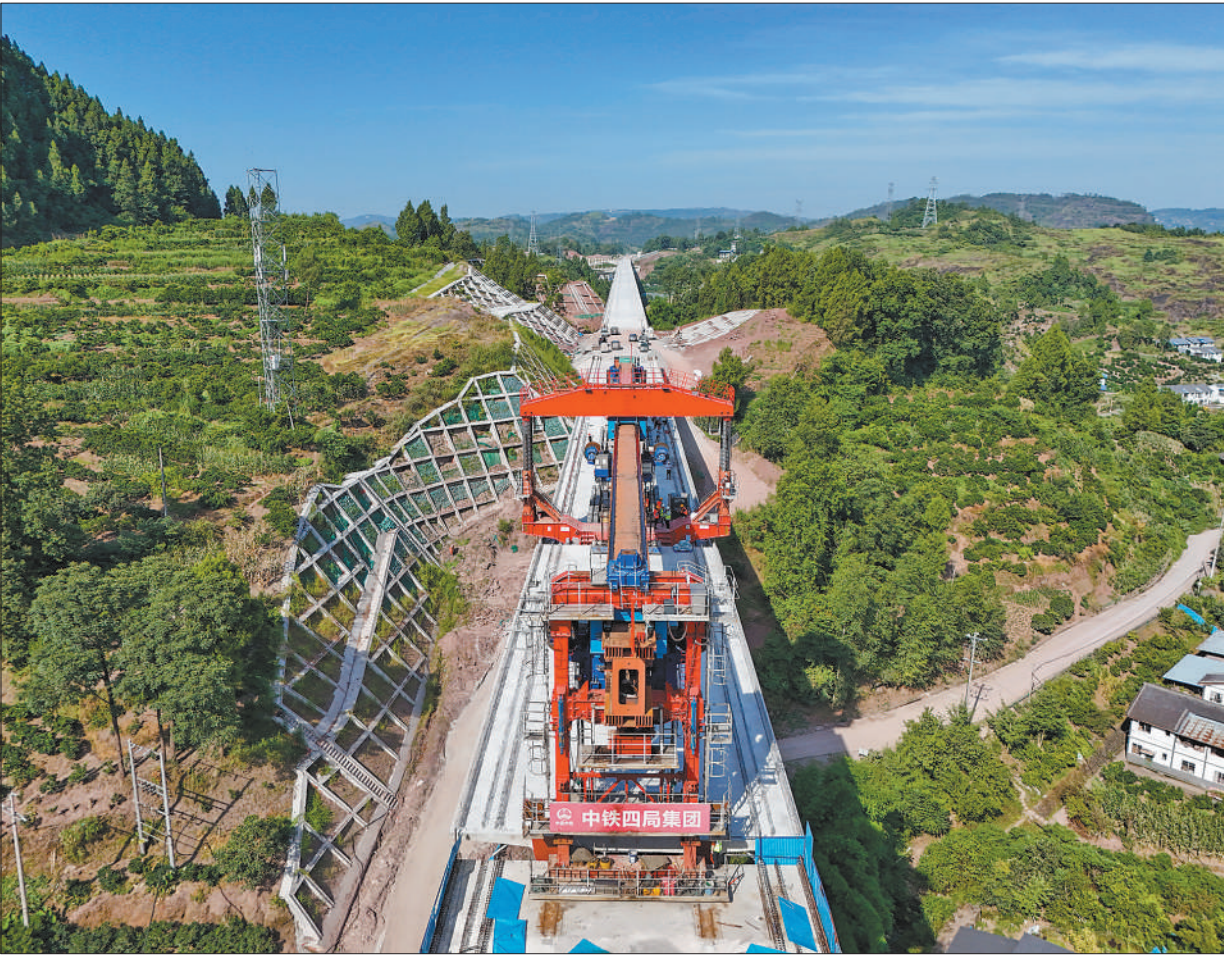
7月14日，最后一孔长32米、重约700吨的箱梁精准落位四川省达州市境内的西渝高铁场坝村跨恩广高速公路大桥桥墩，标志着西渝高铁全线箱梁架设任务顺利完成，为全线按期通车奠定坚实基础。图为西渝高铁场坝村跨恩广高速公路大桥架梁施工作业现场。 新华社记者 王 曦 摄
