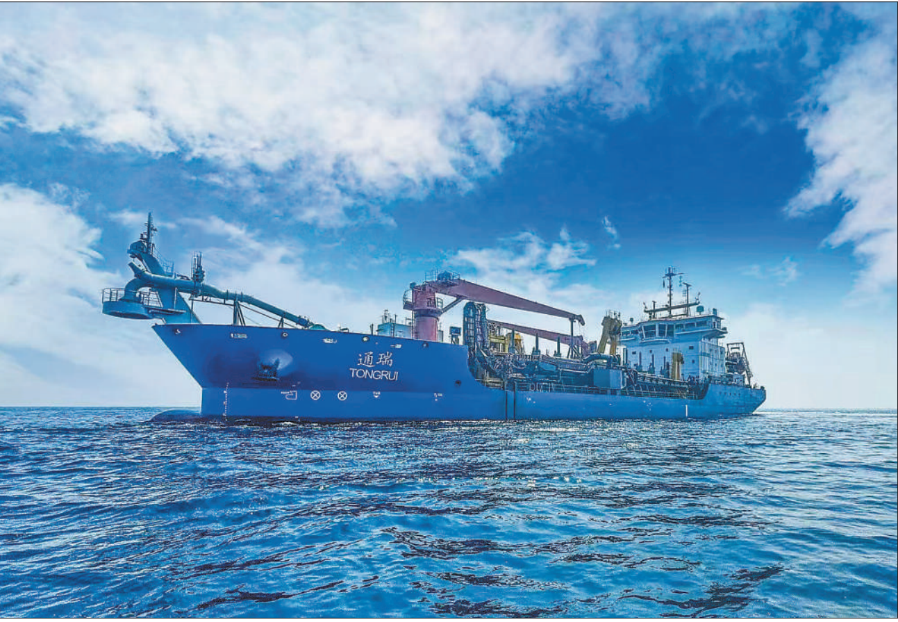
近日，马来西亚安邦加集装箱码头扩建工程重要节点——砂源堆砂及吹砂工程施工任务完成。该任务由中国生产的“通瑞”轮承担，在沙巴州安邦加湾海域完成水下约40米海砂的开采、堆存及转运上岸工作，为码头后续基建及造陆工程提供保障。图为“通瑞”轮在沙巴州安邦加湾海域作业。中国交通建设(马来西亚)有限公司供图
