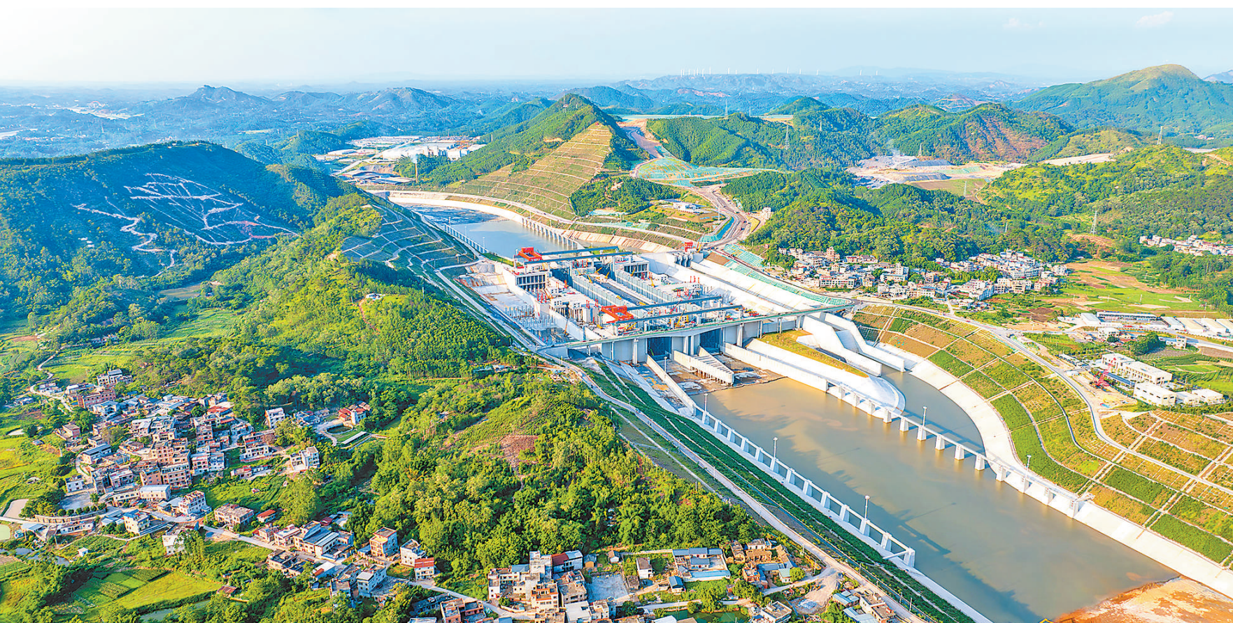
新中国成立以来建设的首条通江达海的大运河 平陆运河全线通水
