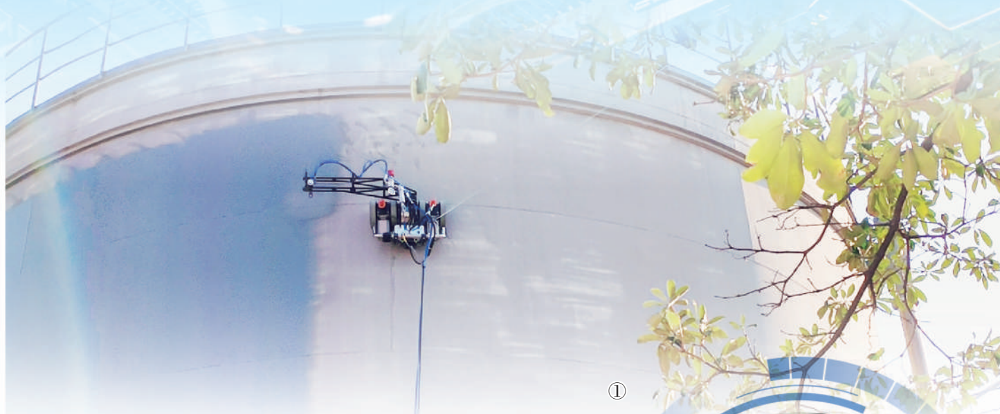
图①:多功能防腐机器人在对石化储罐外壁进行喷漆作业。彼合彼方机器人(天津)有限公司供图
