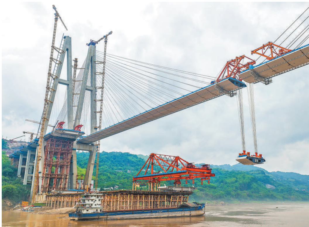
5月27日,新建重庆至万州高速铁路(渝万高铁)全线控制性工程石沱长江大桥合龙,标志着渝万高铁全线149座桥梁全部合龙。石沱长江大桥位于重庆市涪陵区,创新采用公铁合建双塔塔架结构,铁路部分桥梁于5月27日合龙,公路部分桥梁将于今年年底前合龙。
