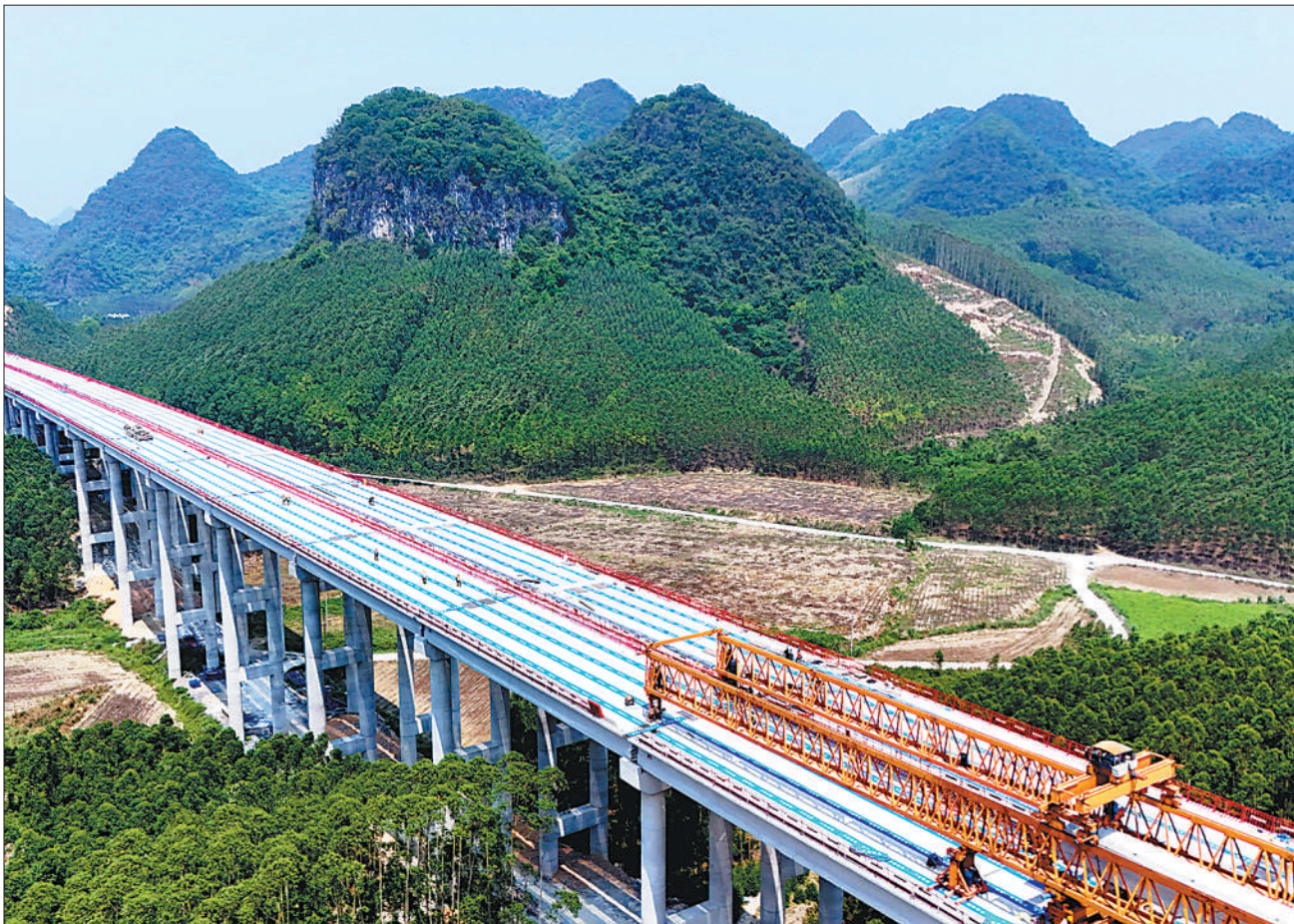
4月10日，广西梧州至乐业高速公路（鱼峰至宜州段）抢抓工期，有序推进。鱼宜高速是广西高速公路网“横五线”的重要组成部分，主线横跨柳州、来宾、河池三市，预计2027年建成通车。图为鱼宜高速木吉河大桥箱梁架设作业正在进行。樊绍光摄（人民视觉）
