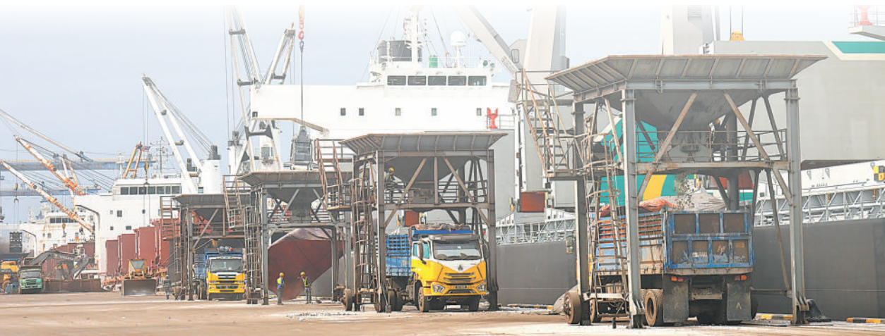
关丹港码头,卸船机正在作业。
