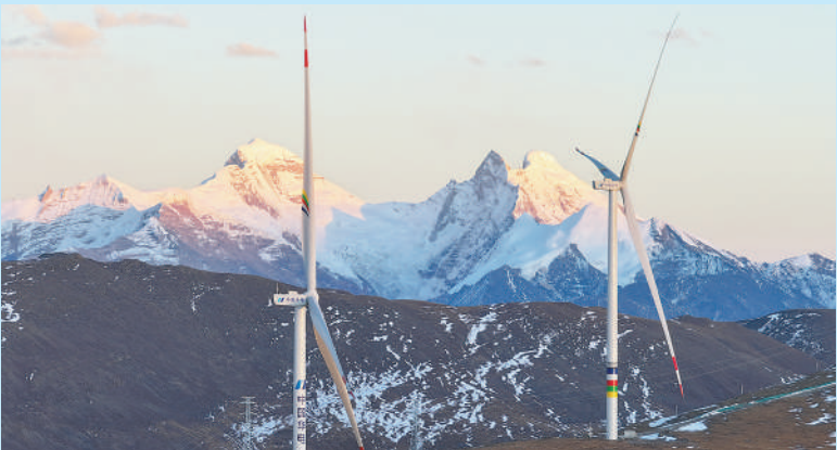
中国华电西藏琼结风电项目，机位点最高海拔5370米，总装机容量60兆瓦，安装12台风电机组，同步配套建设构网型储能系统。
