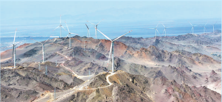
中国华能新疆吐鲁番市100万千瓦风电项目，风机最大可抵抗瞬时风速57米/秒，较常规机组提升约14%。
