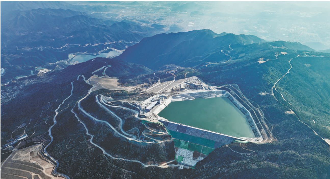
12月25日,浙江天台抽水蓄能电站首台机组正式并网发电,该机组单机容量为42.5万千瓦,是目前国内单机容量最大的抽水蓄能机组。天台抽水蓄能电站总装机容量170万千瓦,建成后将有效助力新能源消纳、保障电网安全稳定运行。“十四五”时期,我国抽水蓄能产业实现快速发展,全国抽水蓄能电站总装机容量超6200万千瓦,总装机容量连续9年居世界首位。图为天台抽水蓄能电站上水库与下水库。
