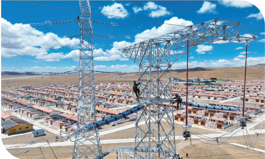
图为国网青海电力公司员工在330千伏玉树二回新建线路开展消缺工作。
