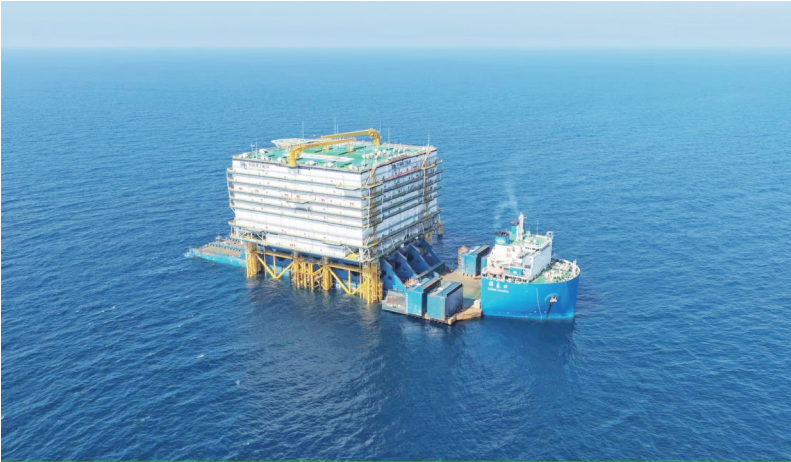
绿电枢纽就位,深远海“动脉”成型,三山岛工程将为粤港澳大湾区构建起一条稳定高效的深远海绿电专属输送通道。 方楚彬/摄
