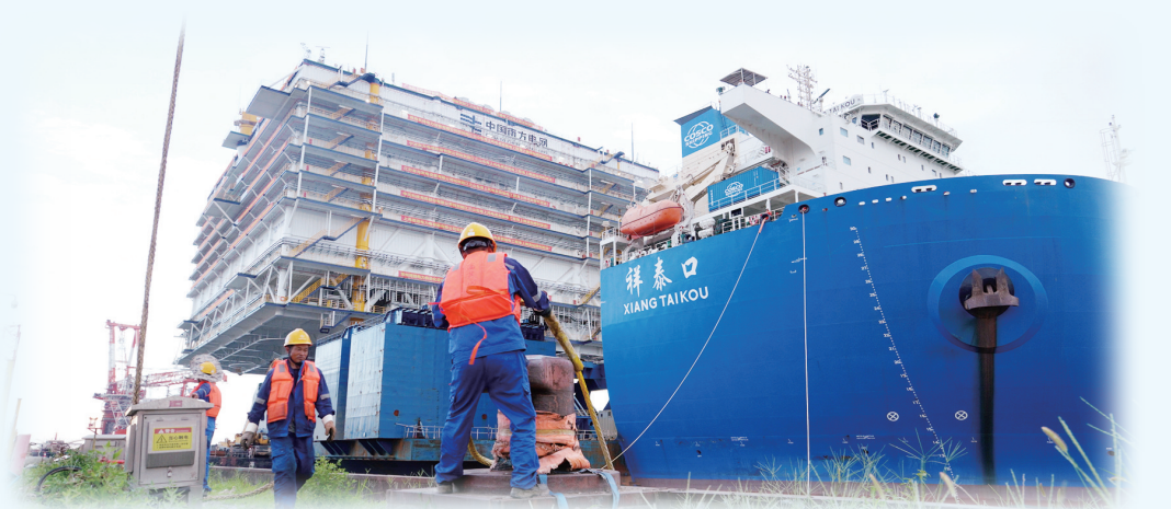
图为7月7日，阳江三山岛海上风电柔直输电工程项目人员有序解开锚索，运输船缓缓离开码头。陈海东/摄
