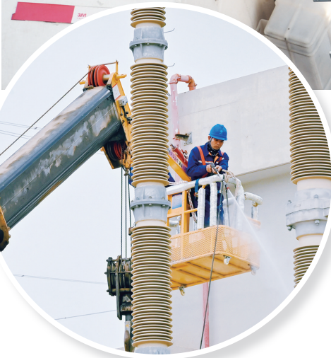
图为国网陕西电力工作人员开展陕西直流年检。马腾/摄
