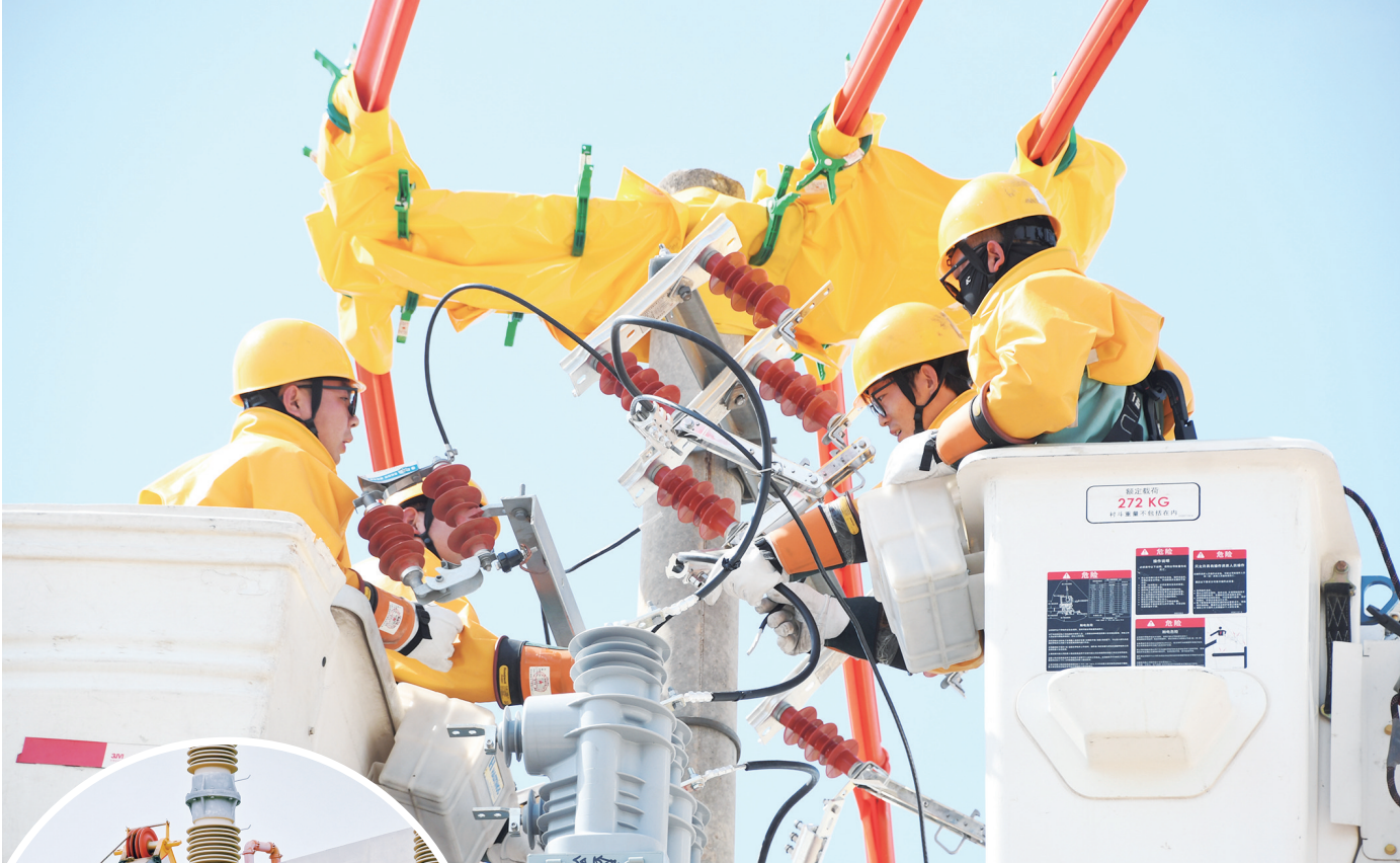
图为国网陕西电力工作人员开展柱上开关升级改造。潘世策/摄
