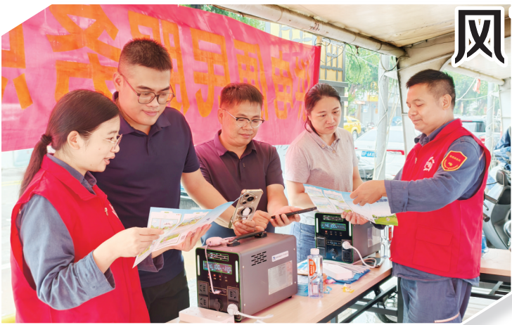
图为南方电网广西防城港防城供电局设置临时便民充电点位，全力抢修复电的同时切实保障居民基本充电需求。郑菊/摄
