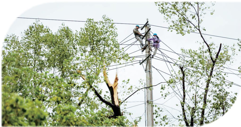
图为7月7日,国网湖北电力员工抢修队伍紧急出动开展线路处置,全力守护辖区群众安全可靠用电。
