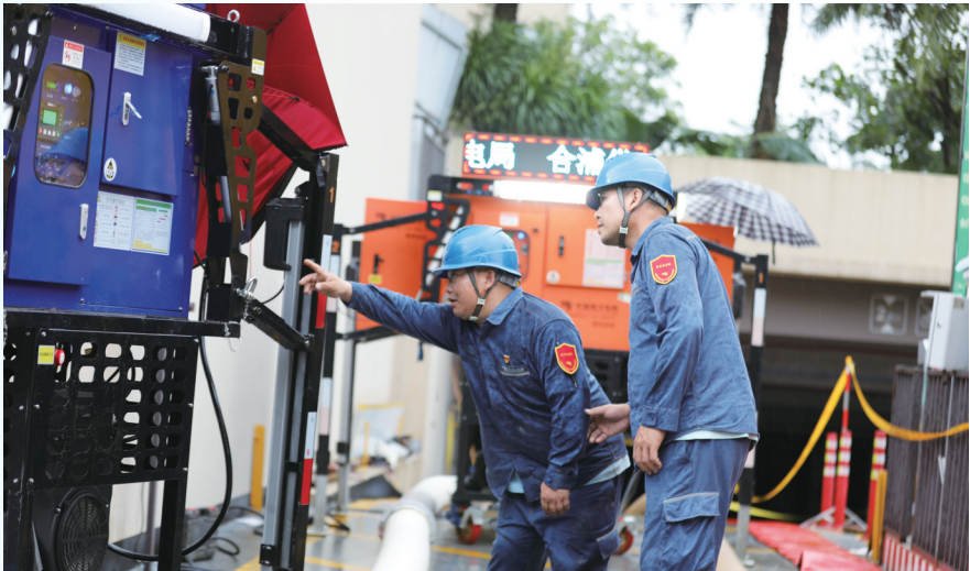
▲7月8日,南方电网广西百色供电局驰援队伍党员突击队在钦州市彰泰红小区排涝抢修一线排查。
