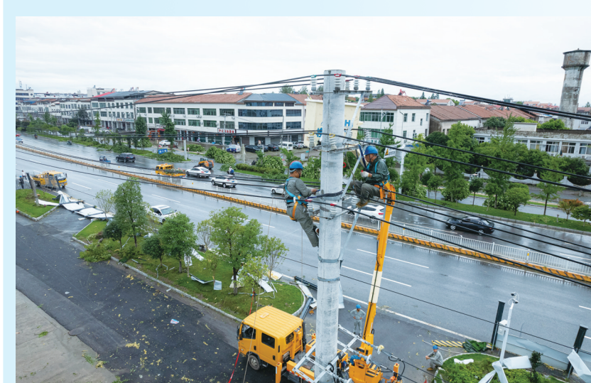
▲7月7日,国网黄冈供电公司应急抢修队在黄州区路口镇10千伏白16祠岗线12号杆处清理线路异物、开展故障处缺工作。
