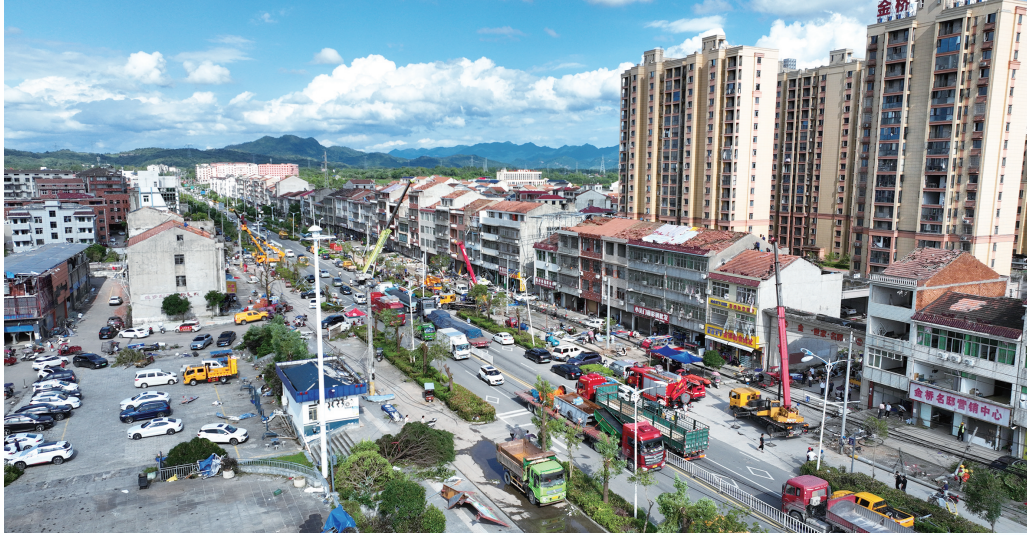
▲7月7日,湖北省供电系统170余人星夜兼程驰援黄石市大冶金牛镇。图为各地方供电公司应急队伍合力抢修受损线路。
