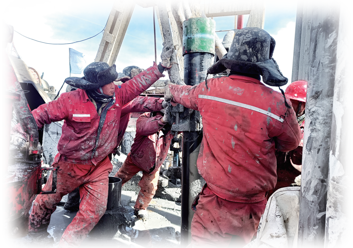
图为山东省地矿局第二水文队地热能勘探现场。
