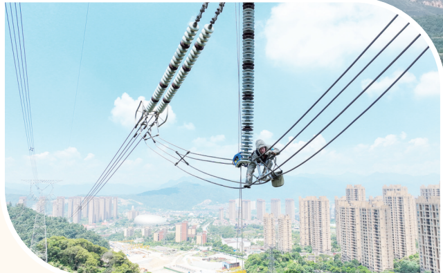
图为7月9日，国网福州供电公司输电带电作业人员在福州市连江县潘渡镇为500千伏福门Ⅰ路38号塔带电安装防风偏绝缘子，提升线路防风能力。
